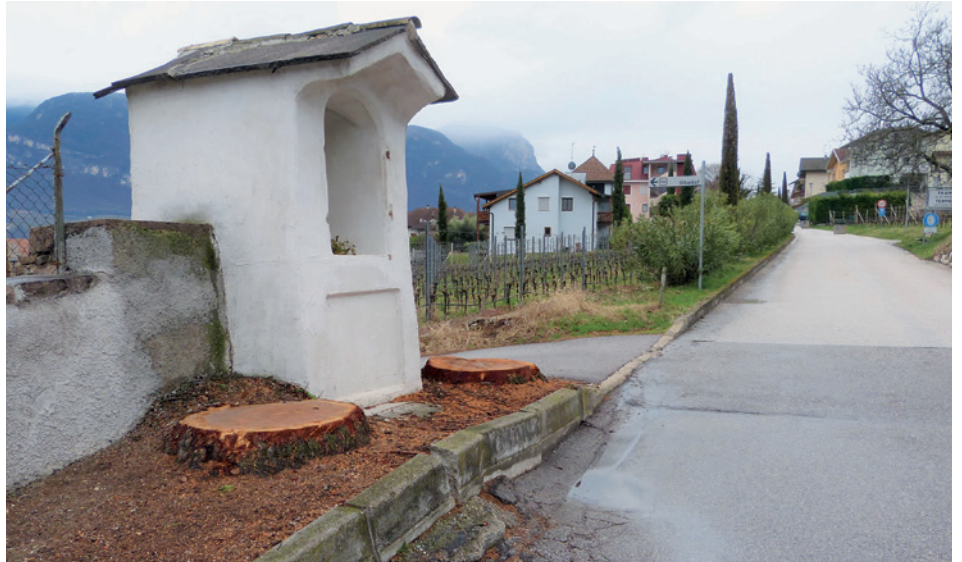
Leer wirkt die Kaltererseestraße ohne die beiden ca. 80 Jahre alten kerngesunden Zedern. Sie mussten weichen, weil ihre Wurzeln die Randsteine, den Straßenbelag sowie die Mauer beschädigten. Die Baumstünke können nicht entfernt werden. Das hätte die sichere Zerstörung der Bildstöckls zur Folge. hgk
